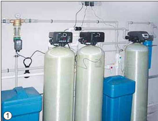
Рис. 29.5. 1. Фільтри для системи очищення води в замському будинку. 2. Фільтрувальник із змінним картриджем
